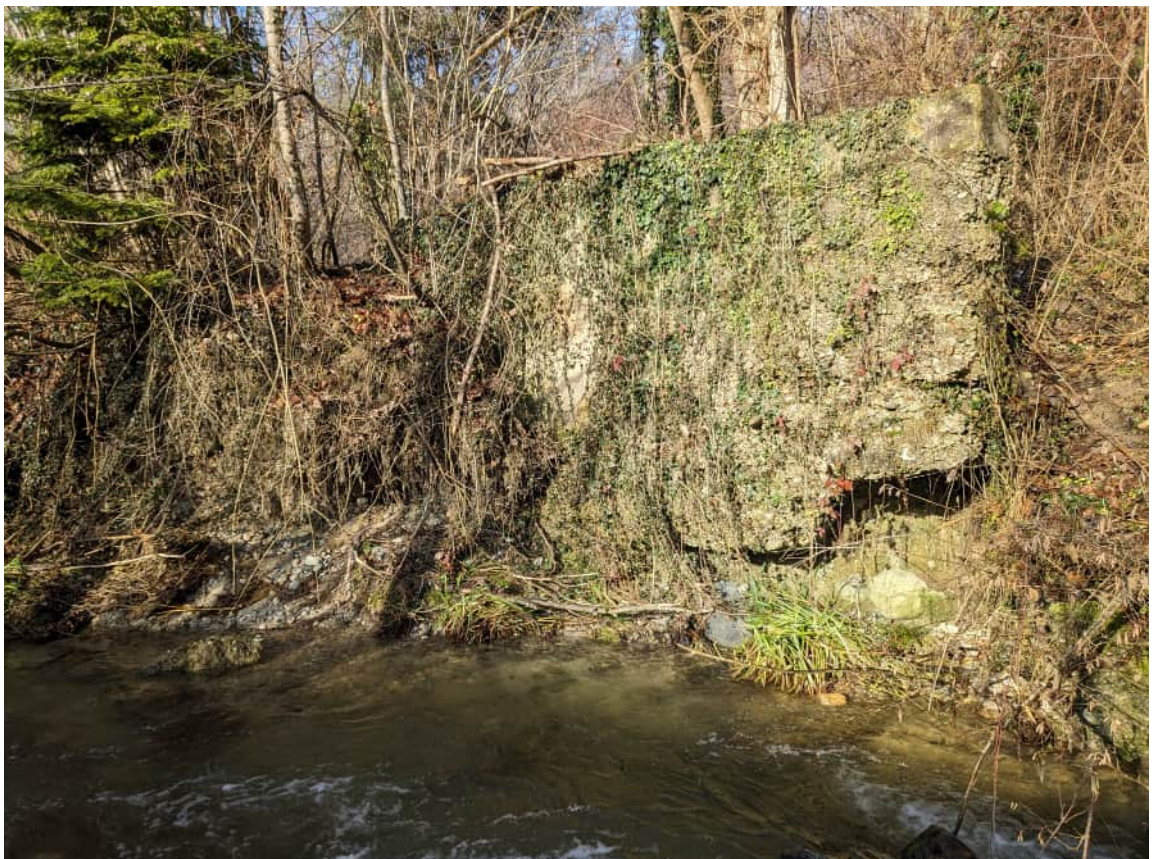
Foto Nr. 6 (19.12.2023 11:41): km 2.220 rechts Ufer
