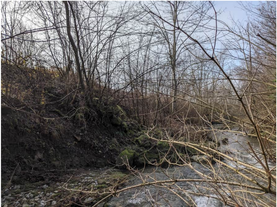
Foto Nr. 3 (19.12.2023 11:38): km 2.280 stromabwärts
