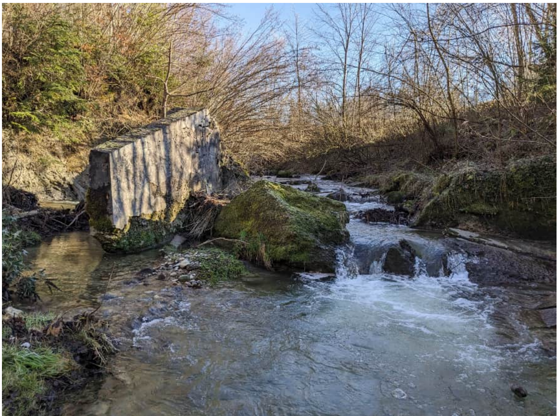
Foto Nr. 8 (19.12.2023 11:58): km 2.160 stromaufwärts
