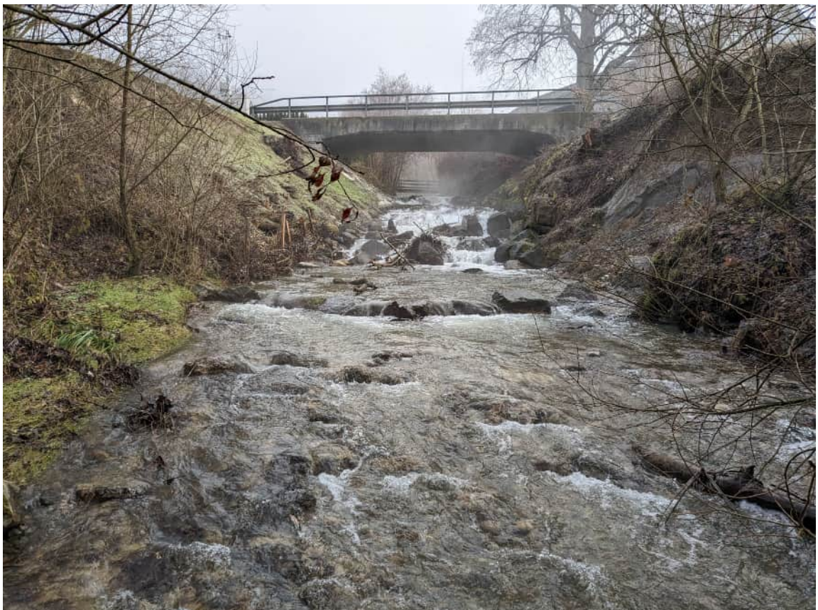
Foto Nr. 2 (19.12.2023 11:30): km 2.280 stromaufwärts
