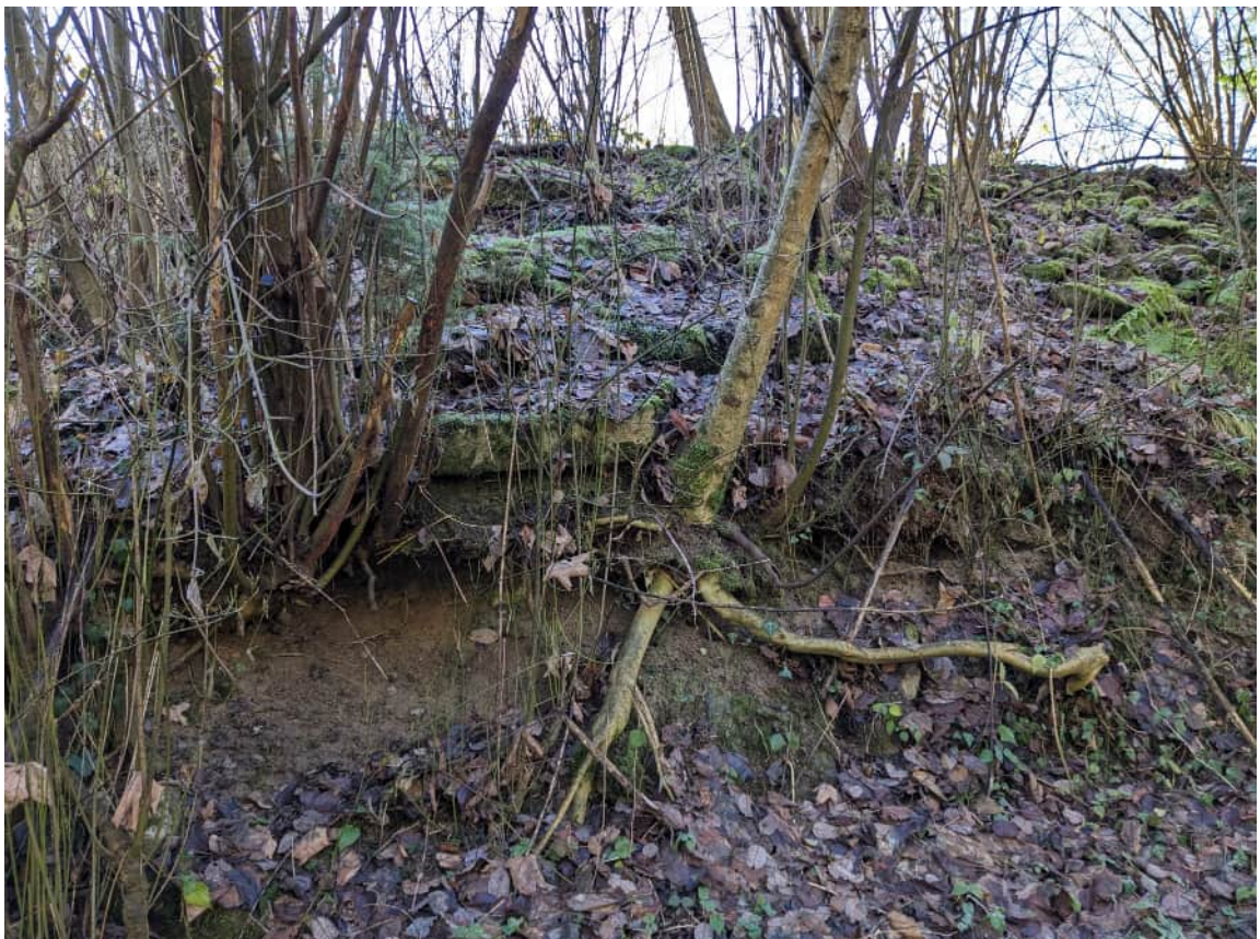
Foto Nr. 10 (19.12.2023 12:05): km 2.160 linkes Ufer
