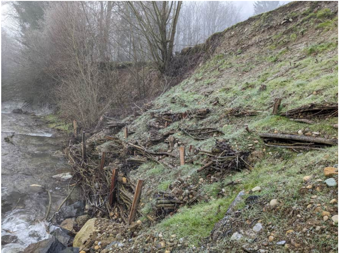
Foto Nr. 1 (19.12.2023 11:22): km 2.315 stromabwärts
