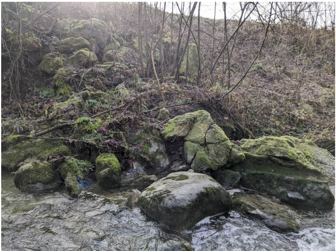
Foto Nr. 4 (19.12.2023 11:39): km 2.260 linkes Ufer
