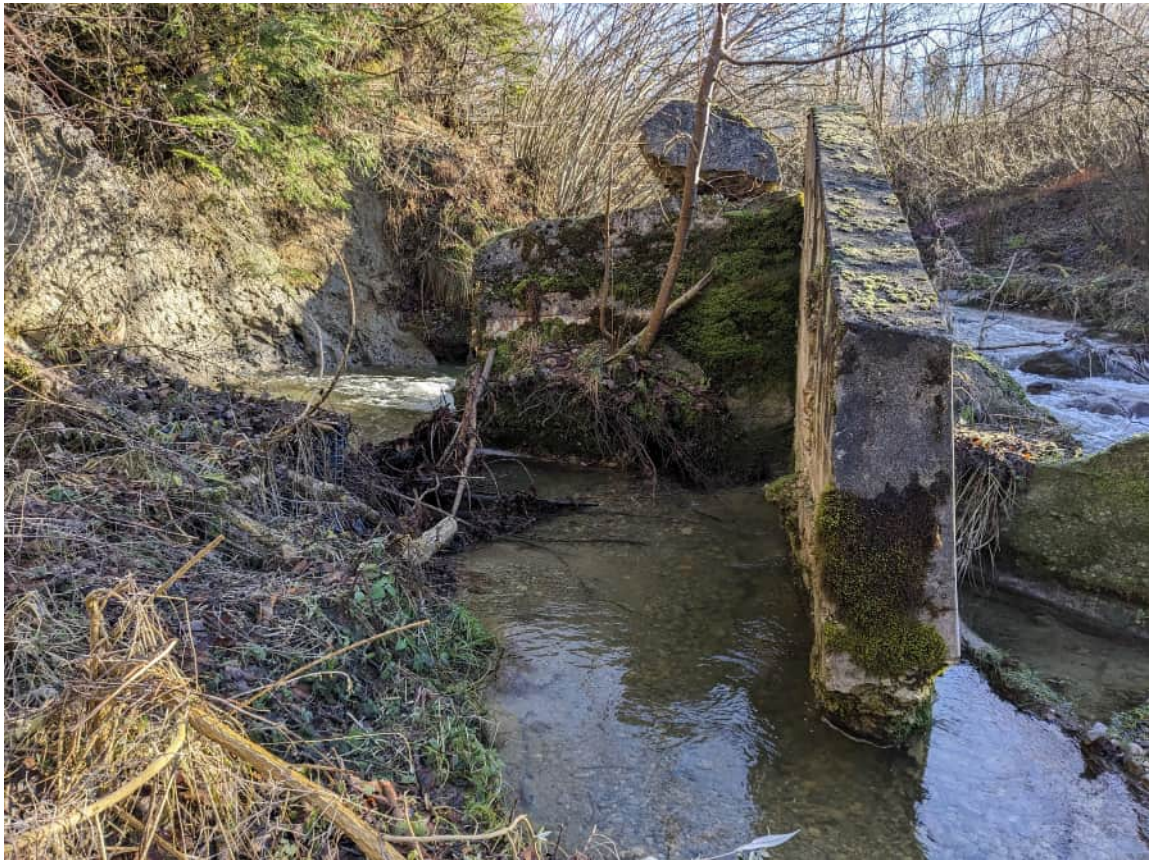
Foto Nr. 9 (19.12.2023 11:58): km 2.170 linkes Ufer
