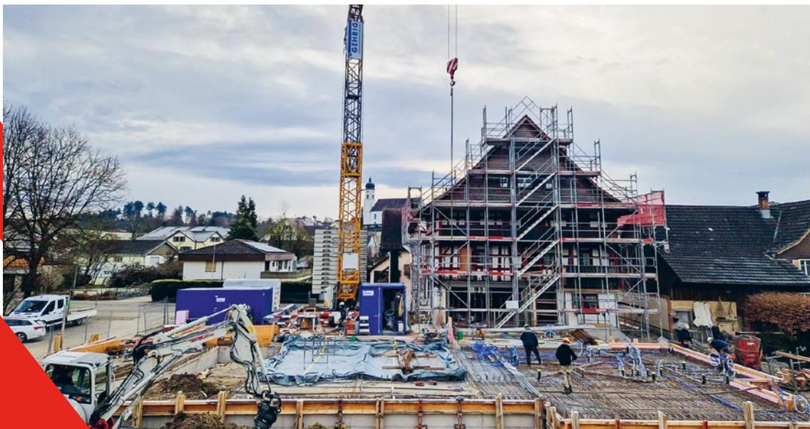
Baufortschritt bei der Sanierung der «Alten Herberge». Im Vordergrund das Fundament des neuen Nebengebäudes.
