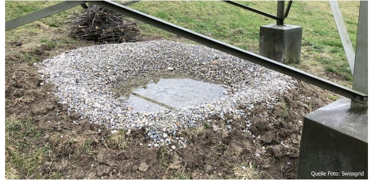
Freileitungsmasten mit einer Kombination verschiedener Kleinstrukturen.
