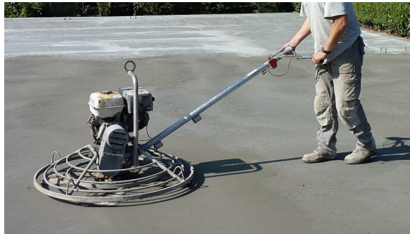
Rotationsglätter für Monobeton
