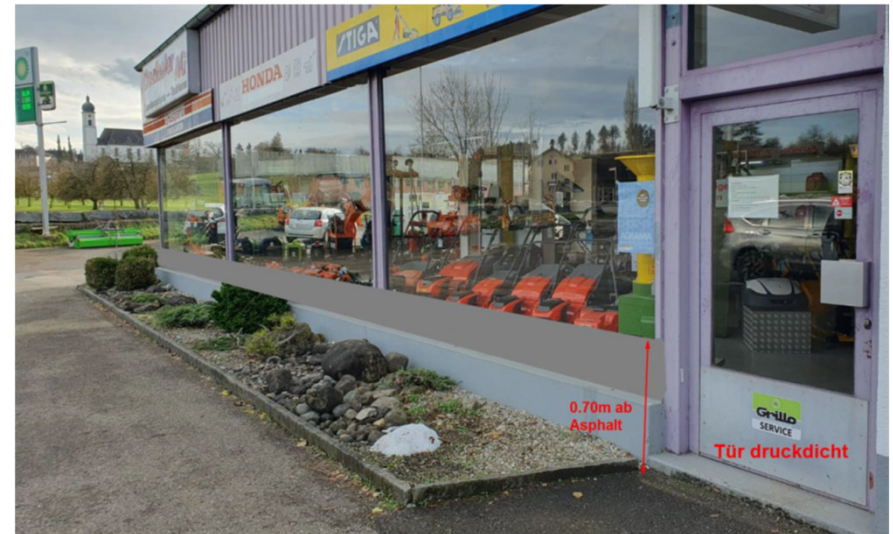
Foto: Beispielfoto einer Hochwasserschutz-Massnahme
