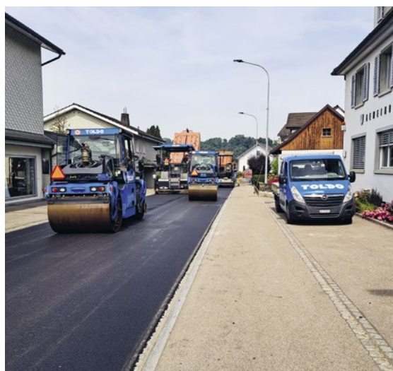
Belagseinbau auf der Gossauerstrasse.
